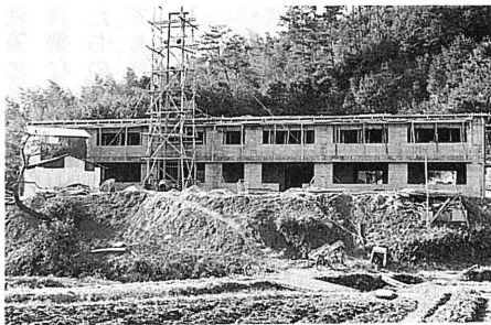
建設途中の松風寮(昭和35年)
