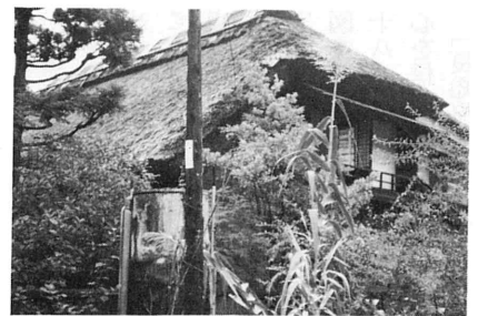
(天井裏の二階)
